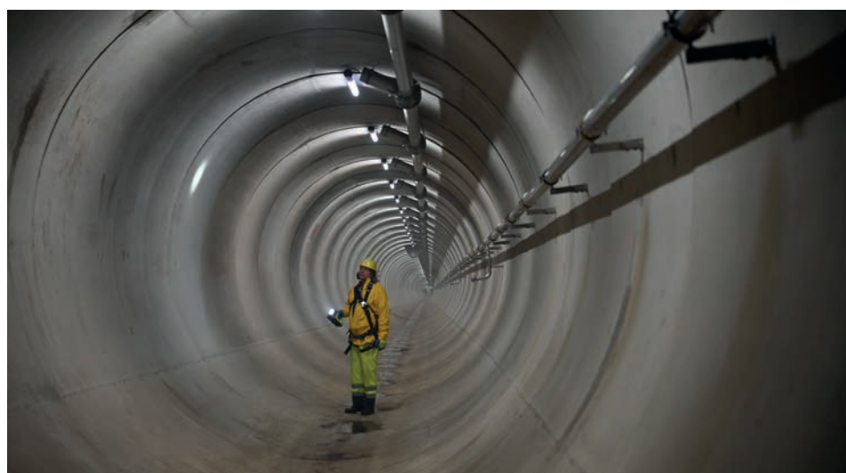
Im Inneren des Stauraumkanals
