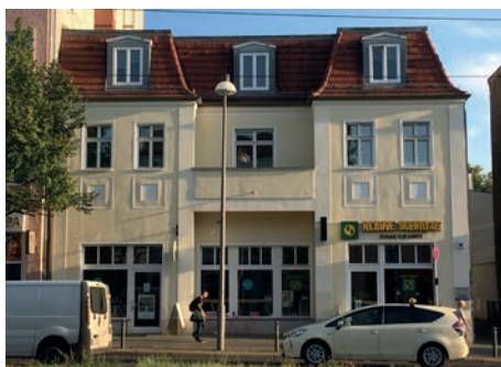
Blick auf das Vorderhaus der Berliner Allee 88
