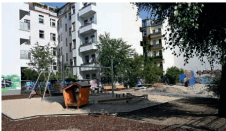
Während der Bauarbeiten in der Jablonskistr. 7-8
