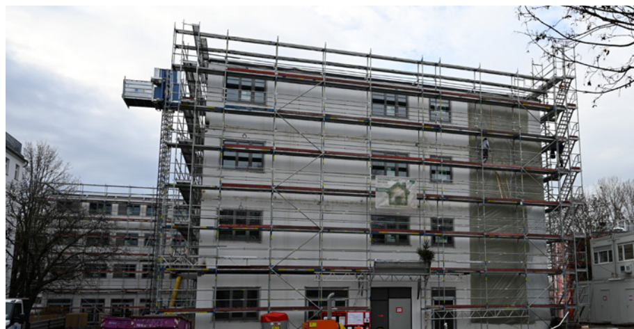
Baustelle der Schuldrehscheibe am Eschengraben
