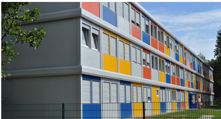
Die Aufnahmeeinrichtung in der Bucher Groscurthstraße wurde in Containerbauweise errichtet und ist seit 2015 in Betrieb.
