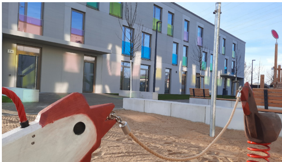
Die Gemeinschaftsunterkunft in der Rennbahnstraße in Weißensee entstand in modularer Bauweise errichtet und ist seit 2021 in Betrieb, Foto: LAF
