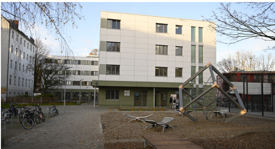
Außenansicht der Schuldrehscheibe Thulestr. 73a
