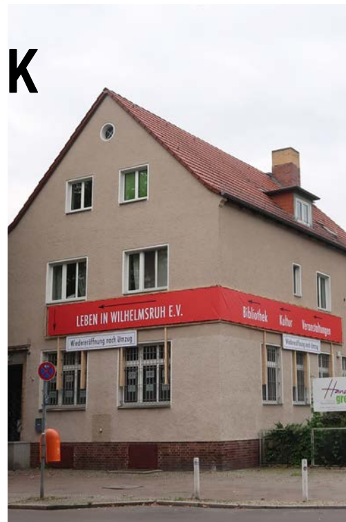
Im Gebäude der KulturPost in der Hauptstraße in Wilhelmsruh ist nun auch die Ehrenamtsbibliothek zu finden.
