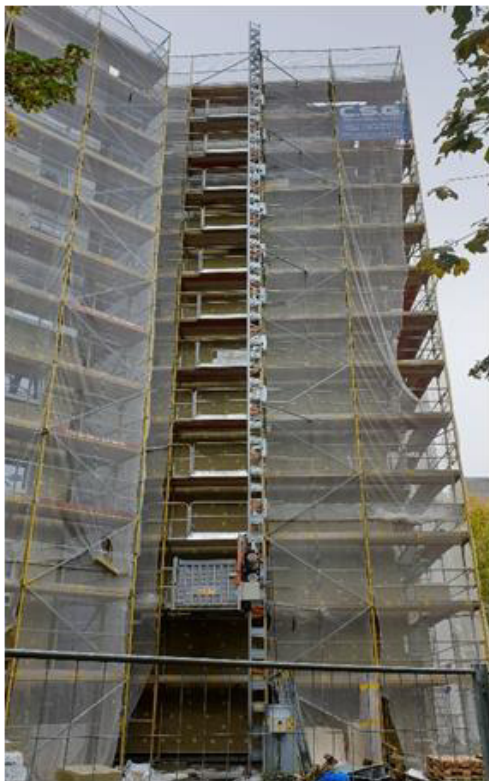
Abbildung 23: Energetische Fassadensanierung an der Lipschitzallee
