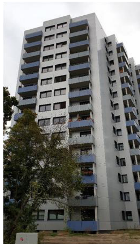
Abbildung 24: Umfassend modernisiertes Punkthochhaus Severingstraße
