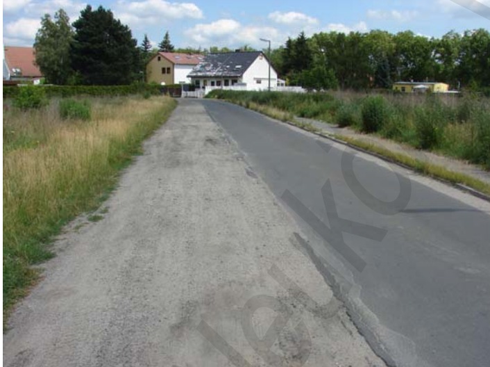
Abb.3 - Gockelweg von West nach Ost in Richtung Rhodeländerweg
