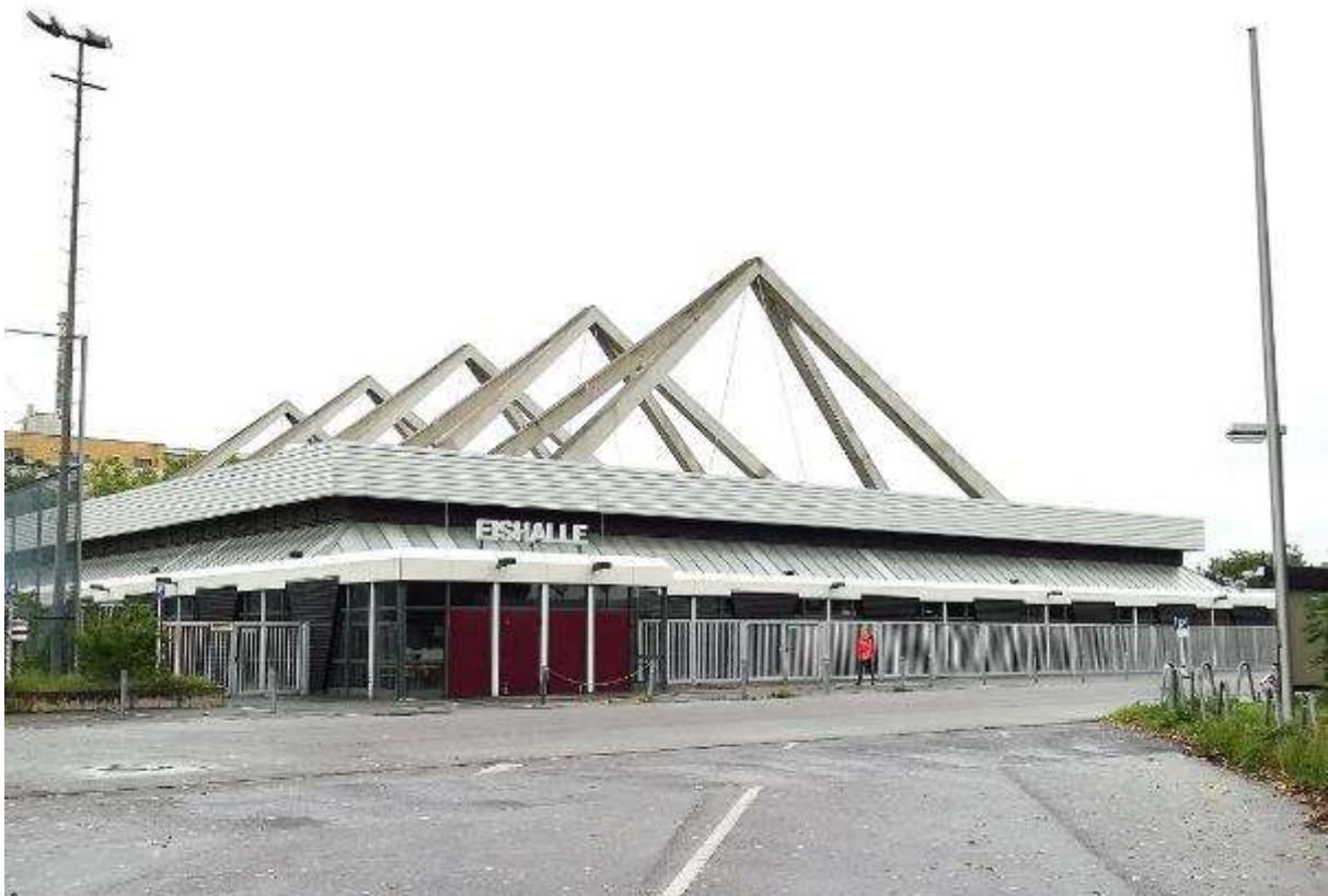
Abbildung 87: Die ungeeigneten Fassaden der Eishalle. Darstellung: Seecon Ingenieure
