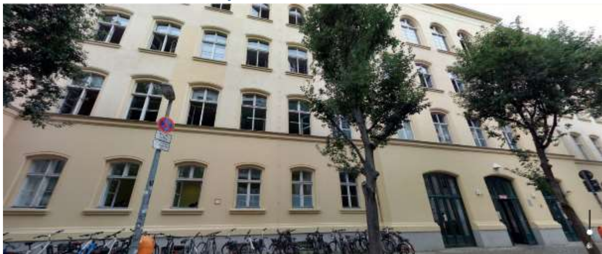
Abbildung 91 Die Außenfassade des John-Lennon-Gymnasiums mit den dicht aneinander gereihten Fenstern. Darstellung: Seecon Ingenieure.
