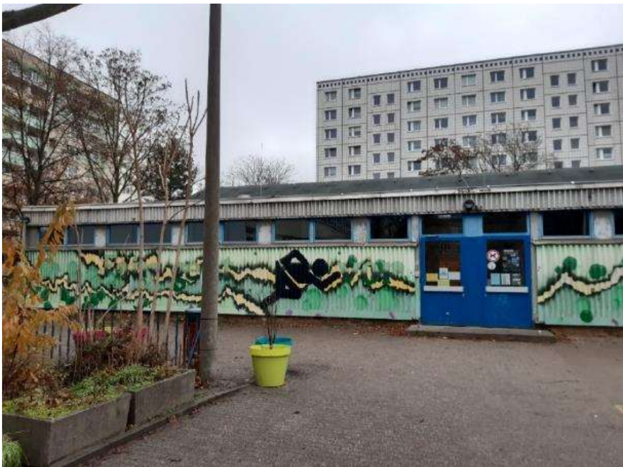
Abbildung 90 Die Blechaußenwände der GutsMuths-Sporthalle. Darstellung: Seecon Ingenieure.
