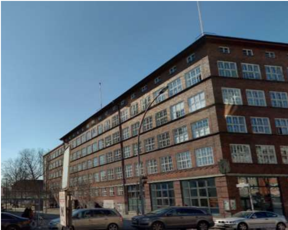
Abbildung 88: Das denkmalgeschützte Rathaus Wedding. Darstellung: Seecon Ingenieure.
