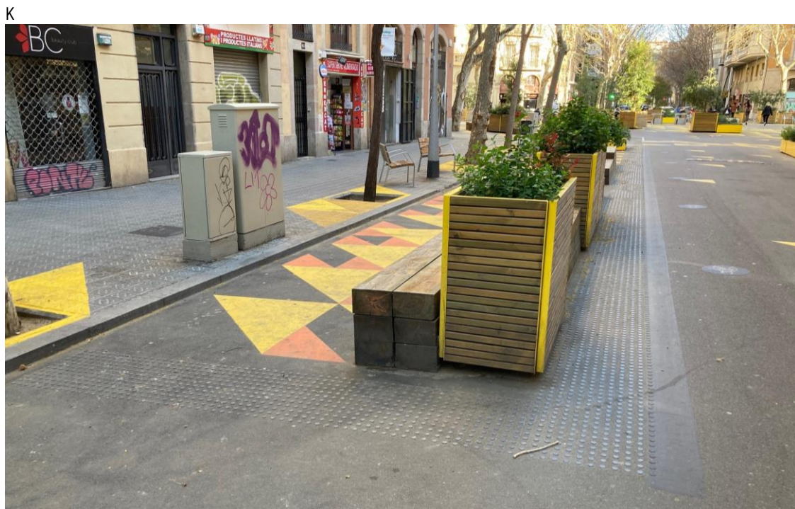
Abbildung 6: Barcelona: Mischverkehrsfläche unter Beibehaltung der Borde mit Blindenleitstreifen
