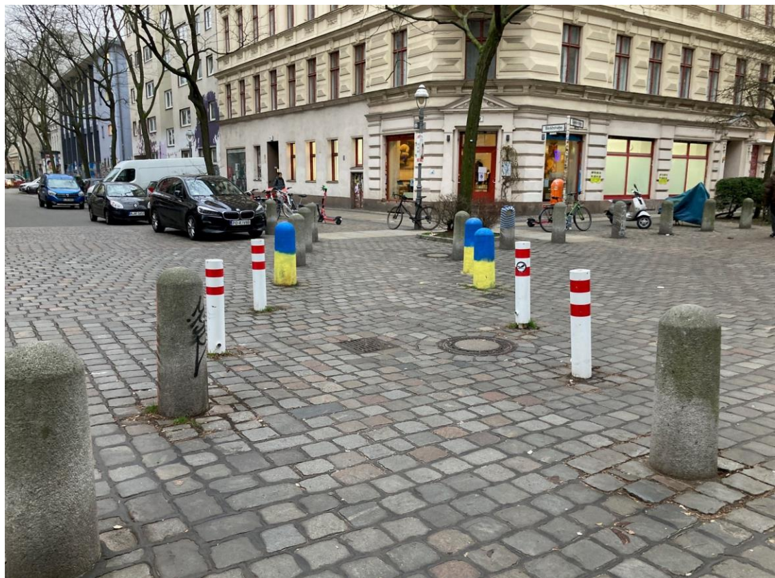
Abbildung 6: Flächige Diagonalsperre Böckhstr. mit sicherer Diagonalquerung für Fußverkehr in einem verkehrsberuhigten Bereich
