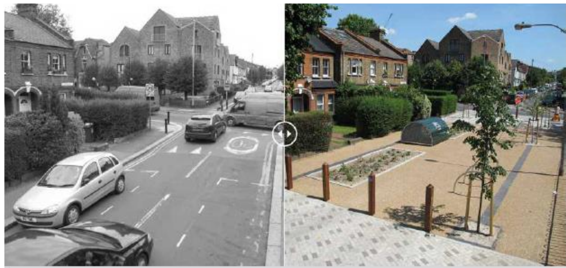
Abbildung 14: Flächige Sperre Waltham Forest Borough / London (vorher - nachher)
