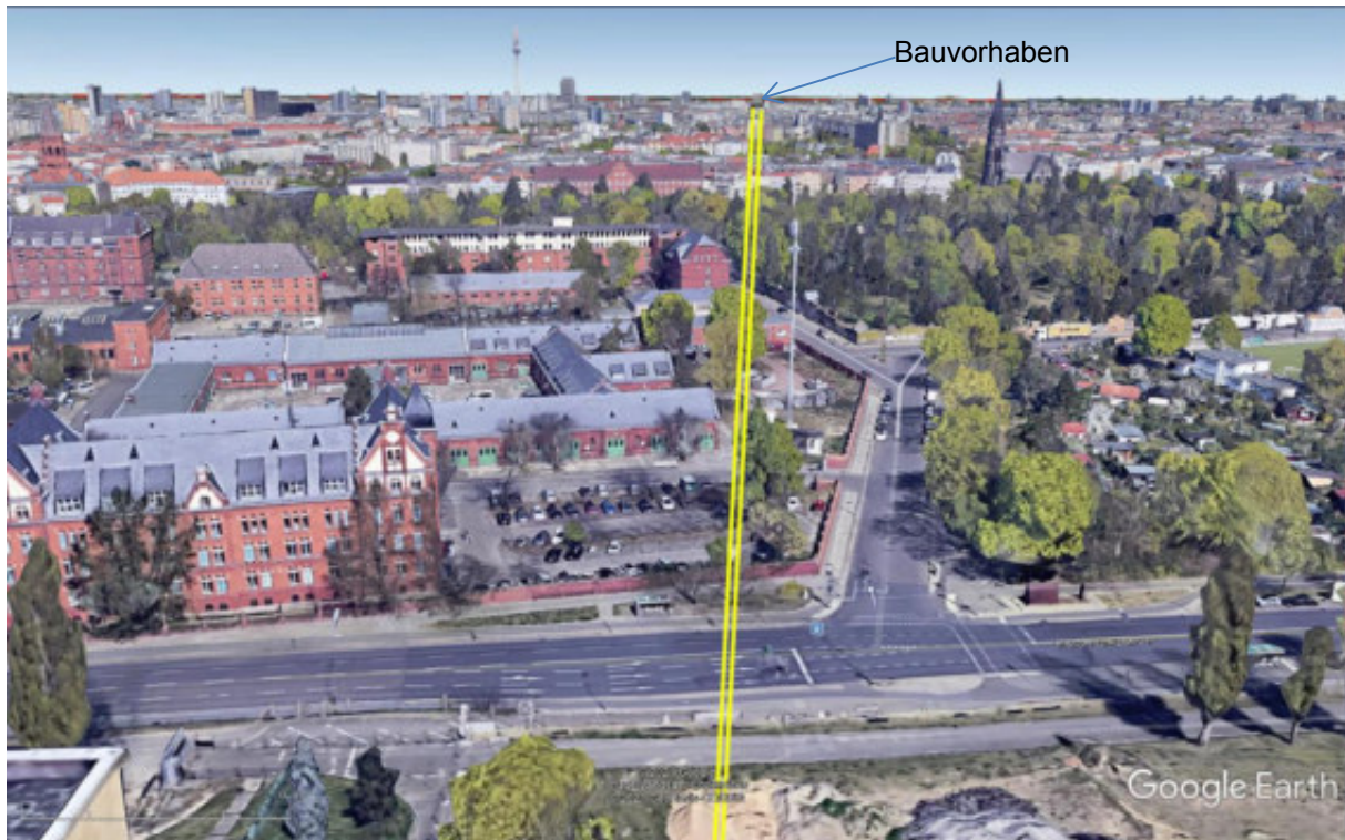
Abbildung 4: Darstellung der Erfassungssituation des Bauvorhabens durch beide Radarsysteme am Radarstandort Tempelhof. Das zu begutachtende Gebäude ist gekennzeichnet.
