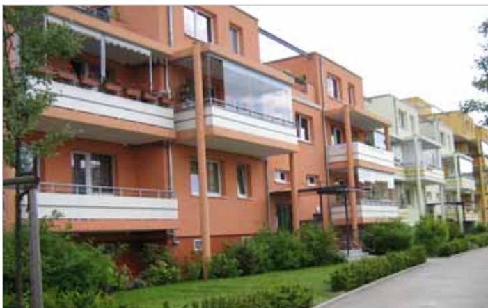
Plattenrückbau Ahrensfelder Terrassen
