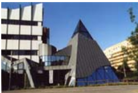
27 Pyramide und Dienstgebäude Riesaer Straße © BA Marzahn-Hellersdorf
