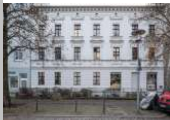
Schlackebetonhaus in der Türschmidtstr. 17
