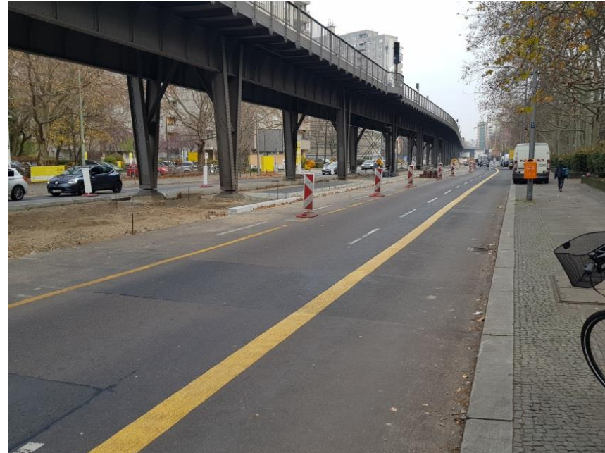
Gitschiner Straße/Prinzenstraße 2. Bauabschnitt
