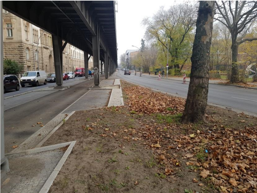
Gitschiner Straße Höhe Zossener Straße 4. Bauabschnitt
