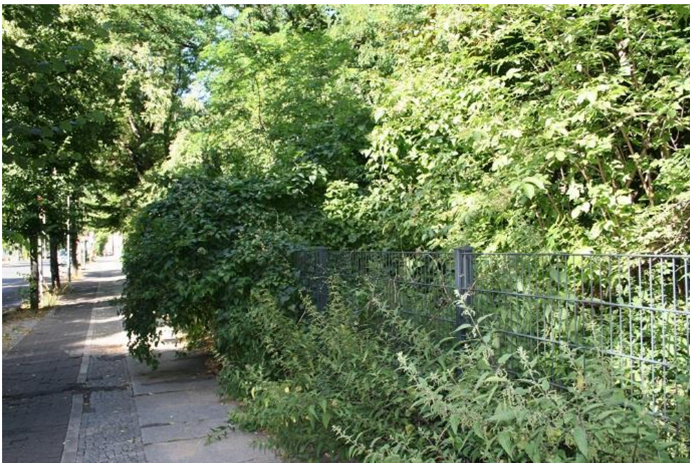
Abb. 23: Bewuchs am westlichen Zaun
