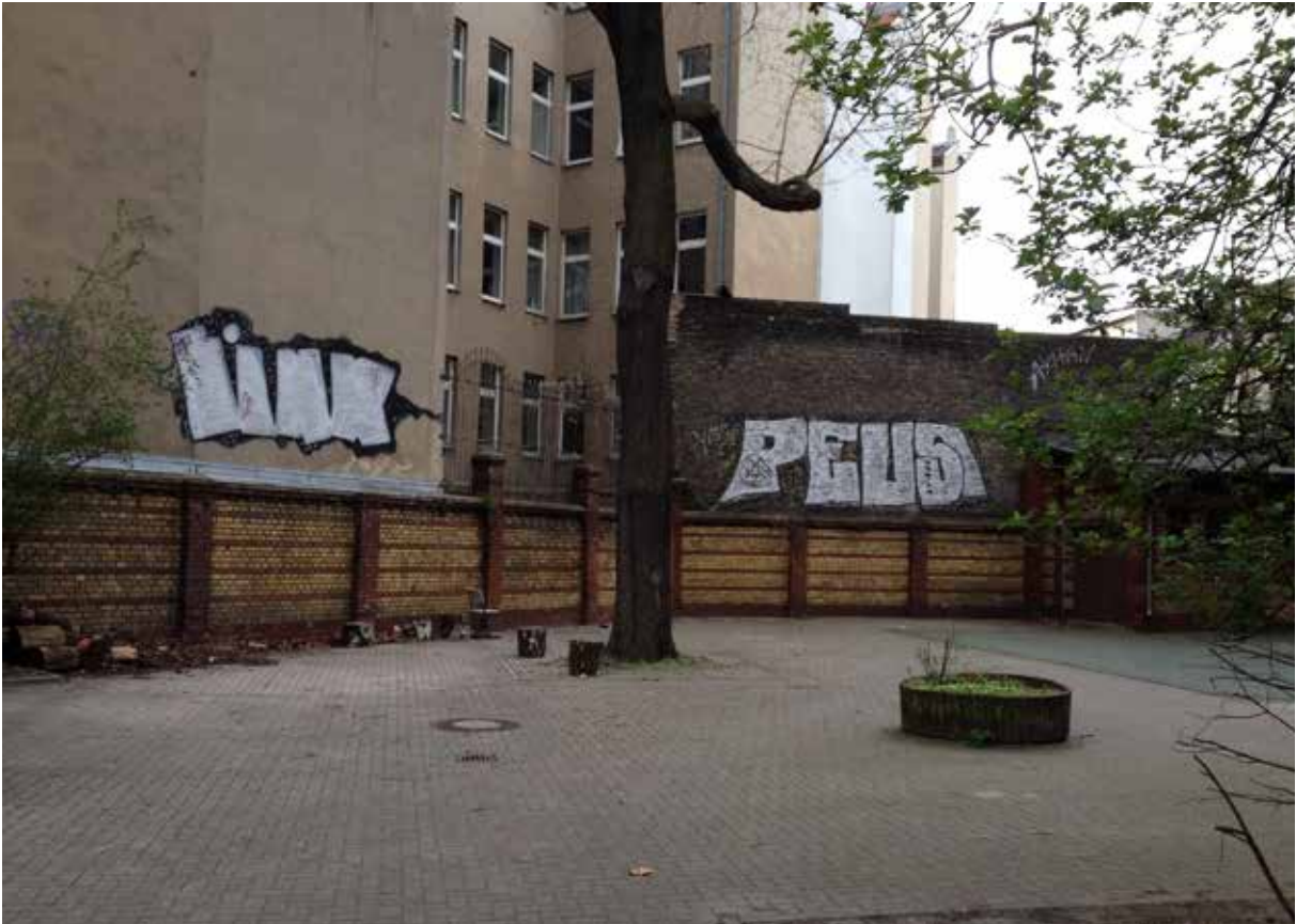
Mauer entlang der Außenanlage
