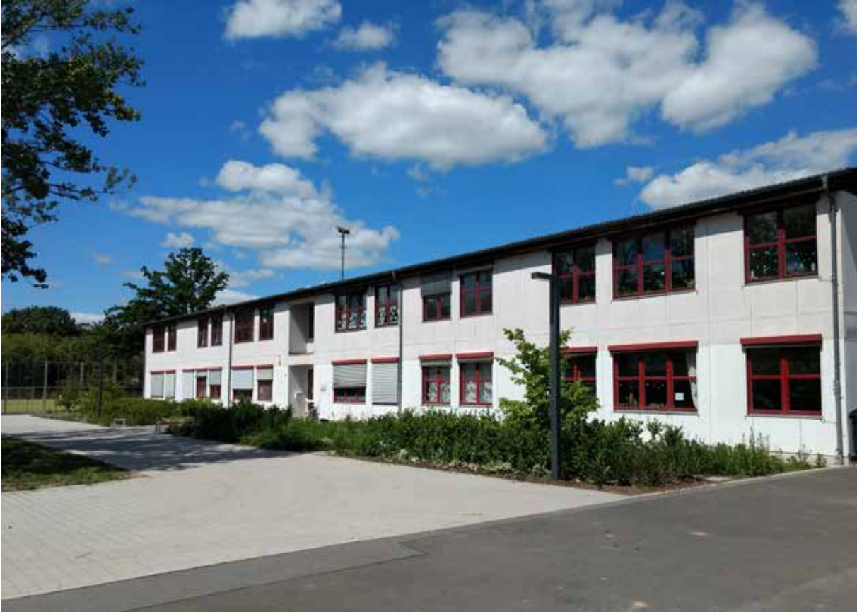
Aziz-Nesin-Grundschule Gebäude mit neuem Außengelände
