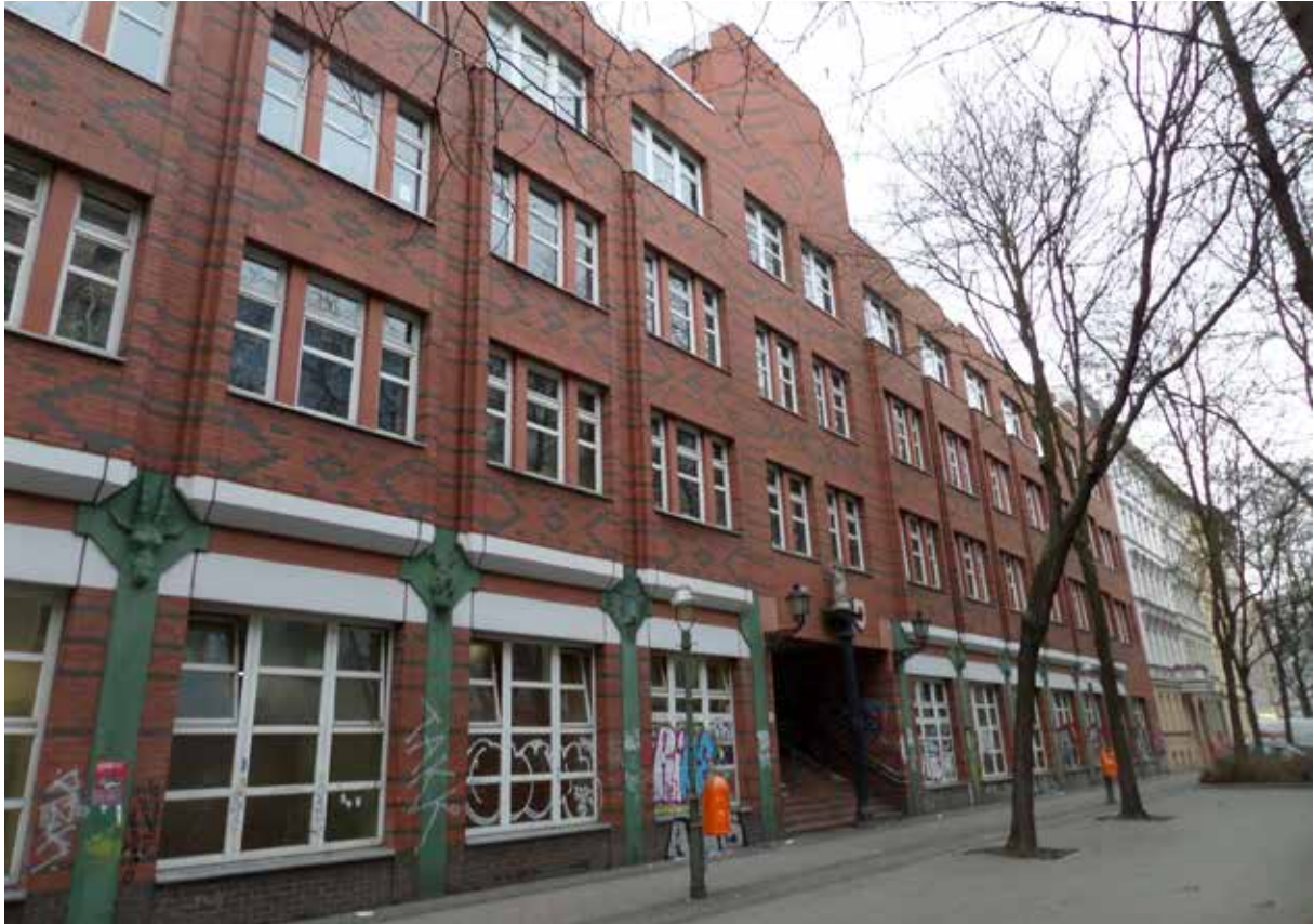
Hauptgebäude der Lemgo-Grundschule
