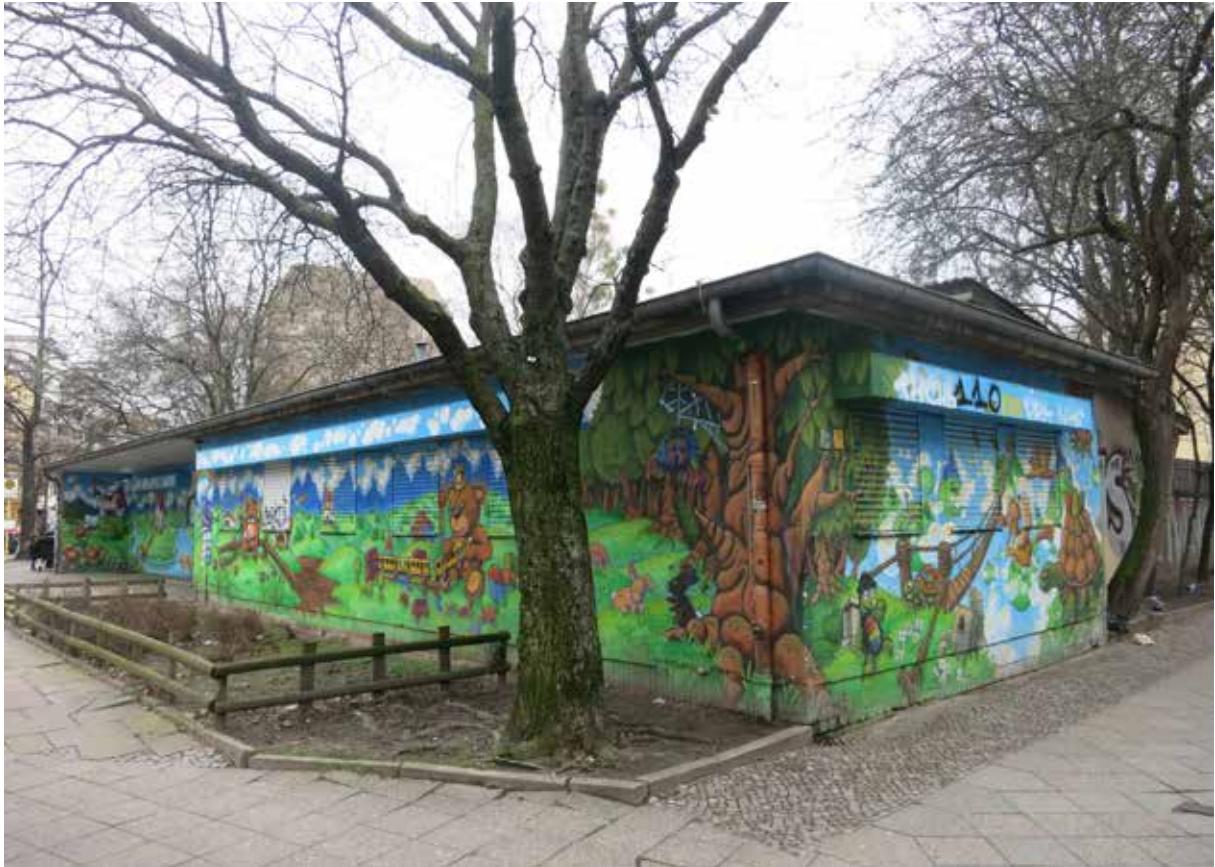
Kita Urbanstraße 62, Blick von Jahnstraße / Ecke Urbanstraße
