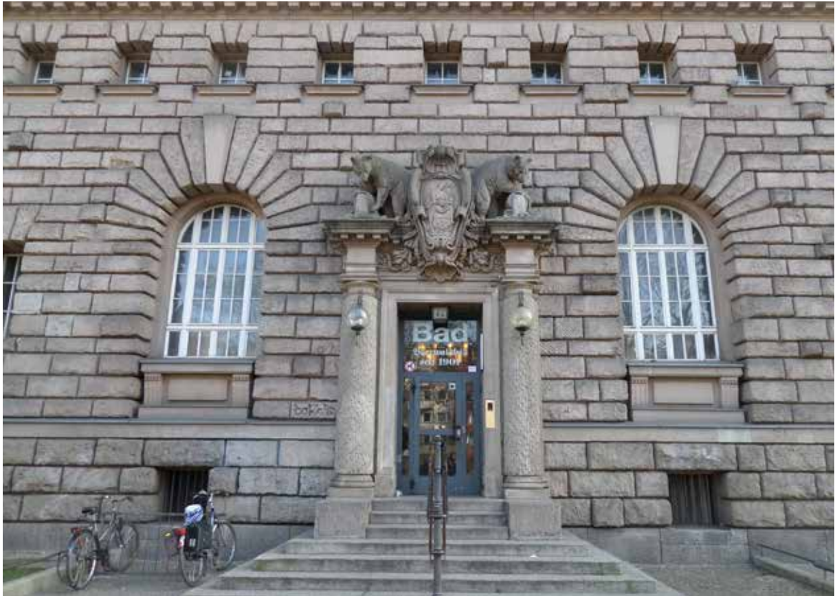
Haupteingang der denkmalgeschützten alten Halle
