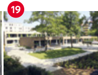
Begegnungszentrum Integral Marchlewskistr. 25e
