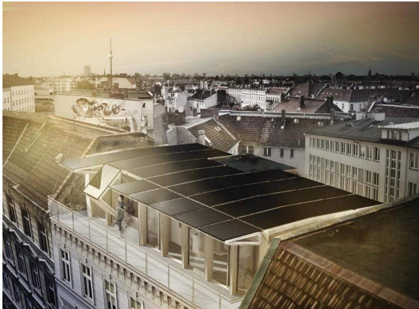
1:1 Projekt: Entwurf, Planung und bauliche Realisierung eines Solar-Plusenergiegedachaufsatzes (Fotovoltaikanlage mit 9,6 \text{ kW}_{\text{peak}} ) für den Gebäudebestand ( https://www.solar-rooftop.de )
