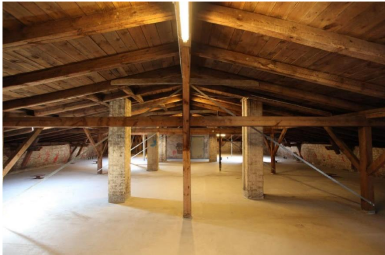
Dachgeschoss im unsanierten Zustand
