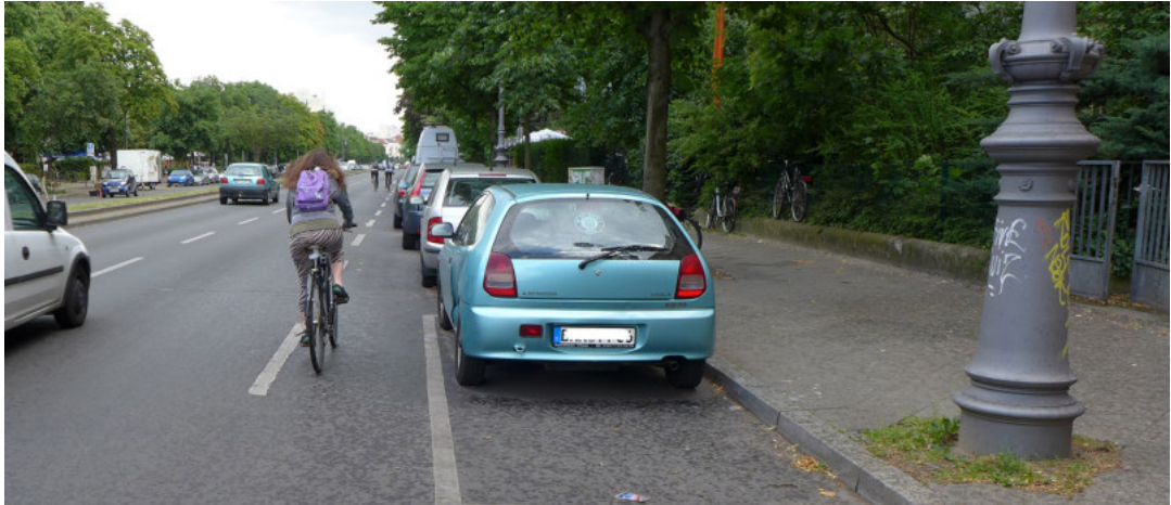
Bild 8 Fehlende Radverkehrsanlagen auf der Hasenheide zwischen Südstern und Hermannplatz. Der rechte der drei Fahrstreifen wurde als Parkstreifen markiert, die Restfahrstreifenbreite wird von vielen Radfahrenden genutzt, es handelt sich jedoch nicht um einen Schutzstreifen
