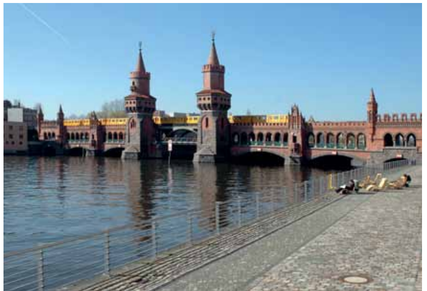
Die Hochbahntrasse der U1 als Bahnanlage mit besonderer Gestaltungsqualität
